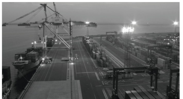
整備の進む「鍋田ふ頭コンテナターミナル」
