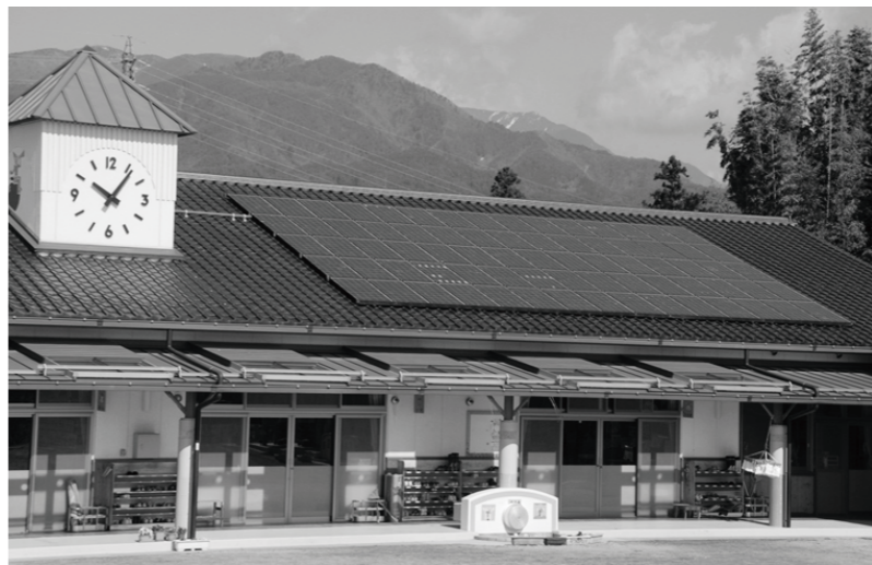
「おひさま発電所設置プロジェクト」による公的施設への太陽光発電システムの設置
