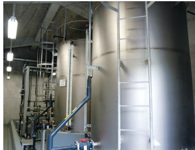
緩速ろ過方式など環境に優しい設備を持つ西野浄水場
