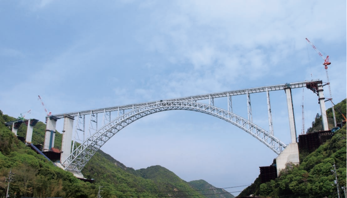
広島空港に向かう広島中央フライトロードのシンボル・空港大橋も完成間近
