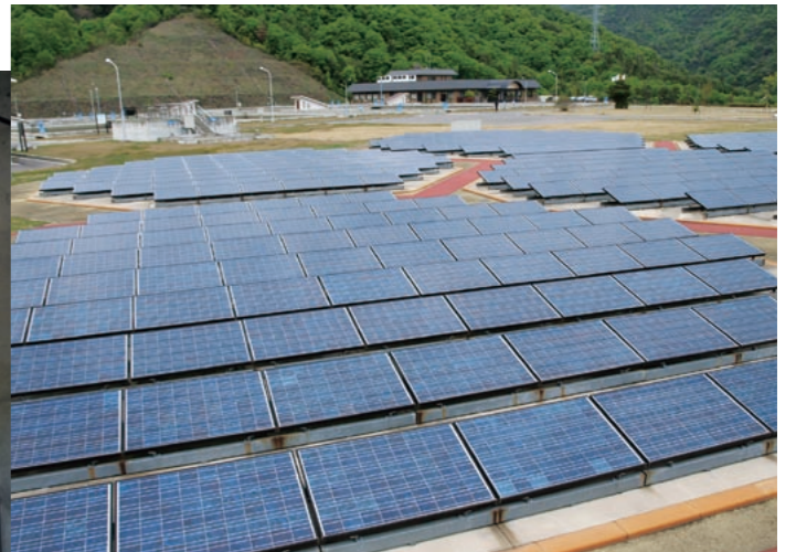
西野浄水場の電力は840枚の太陽光発電モジュールで電気代を大幅に節約
