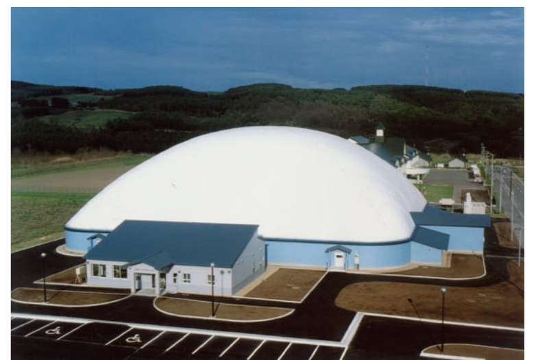
四季を通じてスポーツが楽しめる積雪寒冷地初の空気膜式構造のオホーツクドーム
