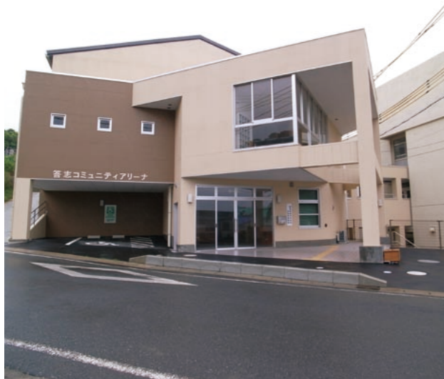
答志小学校(答志島)の隣に完成した屋内運動場(コミュニティアリーナ)
