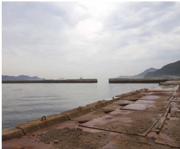
港湾部の整備が進むマリンタウン21の工事現場
