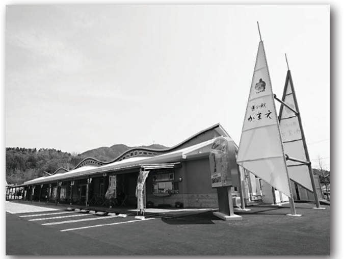
波をイメージした「道の駅かまえ」の屋根
