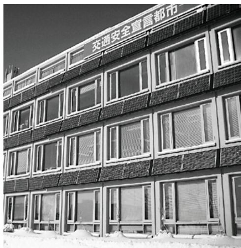
市役所庁舎に設置された太陽光発電パネル
