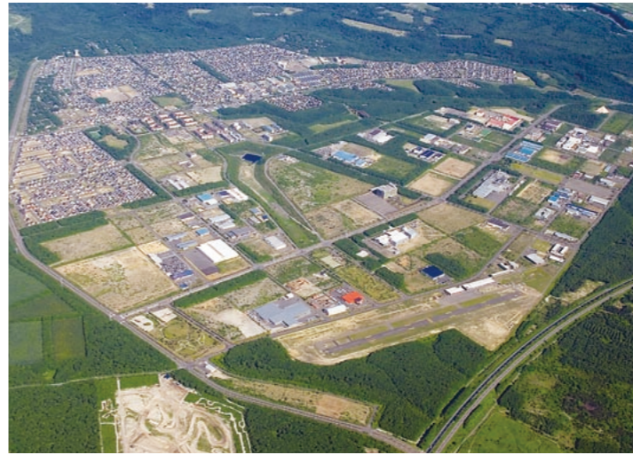
新千歳空港に隣接する「臨空工業団地」
