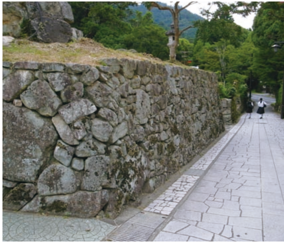
延暦寺と日吉大社の門前町・坂本に残る穴太衆積み堅固な石積み(重要伝統的建造物群保存地区)
