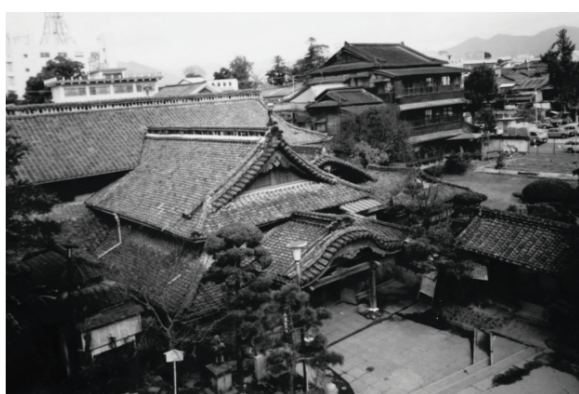
解体前の「さくら湯」の全景
