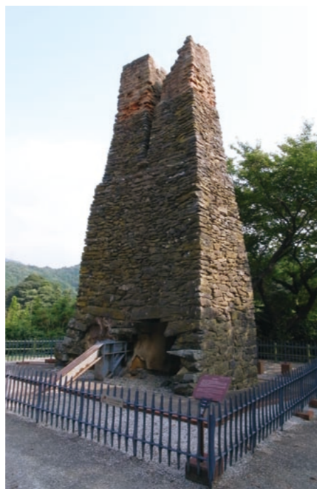
世界文化遺産に暫定登録された萩反射炉（幕末期に洋式鉄製大砲を造るための試験炉として築造）
