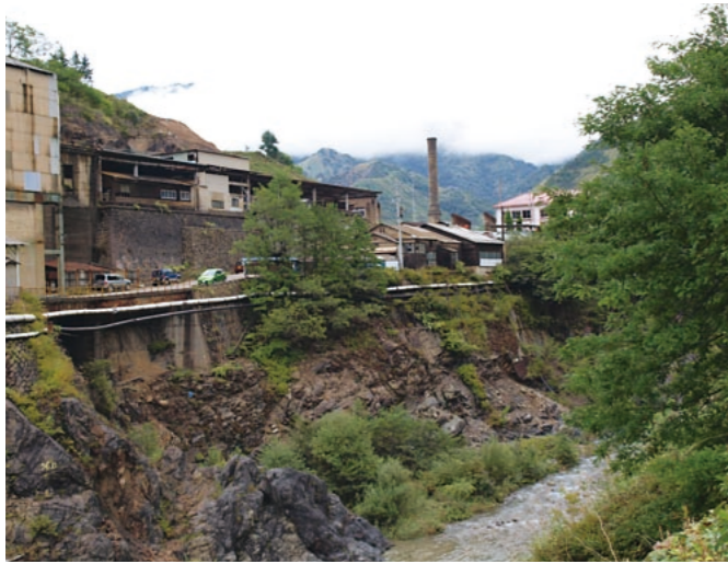
明治17年に開設された本山製錬所(足尾地域)
