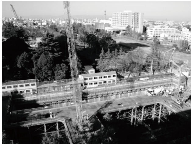
整備が進む警察大学校跡地(平成22年12月)
