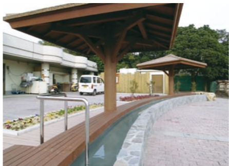
リニューアル工事が進む平川動物公園には桜島を望む足湯も完備
