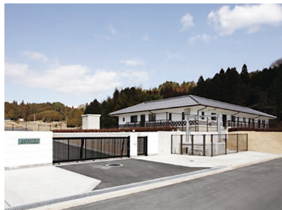
平成19年に完成した農業集落排水事業「福住地区処理場」
