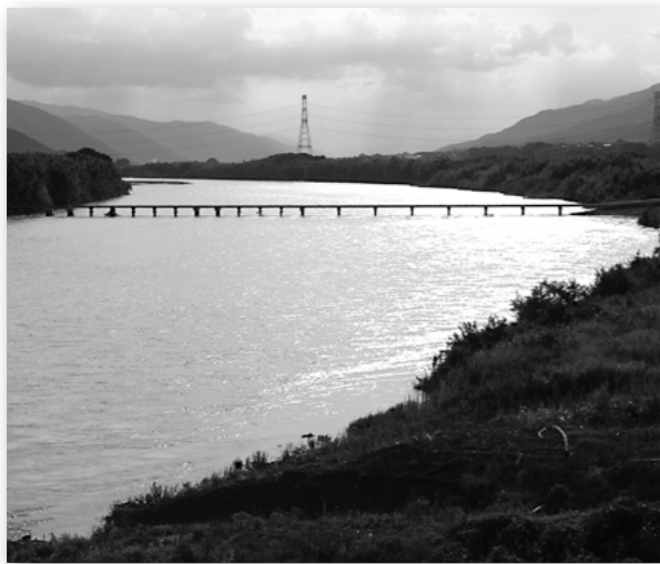
うだつの町並みと舞中島を結ぶ潜水橋
