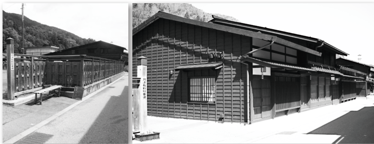
修景事業により三軒の並び家に見える一棟の奈良井公民館（修景前の空地（左側）と現在（右側））
