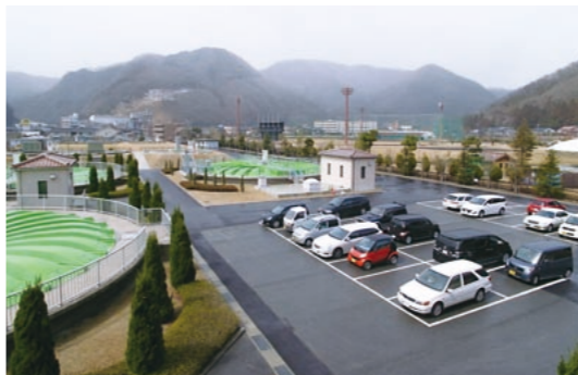
光ファイバーの入線でIT化の推進、管理業務の省力化が図られた下水道施設
