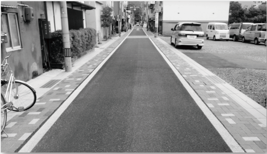
歩車共存道路として路肩を明瞭化した整備例
