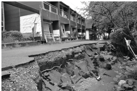
震災で壊滅的被害を受けた公営温泉施設
