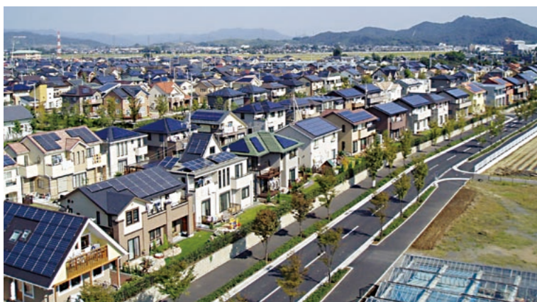
日照量の多い太田市ならではのソーラータウン「Pal Town 城西の杜」。屋根に太陽光発電パネルを載せた住宅がずらりと並ぶ
