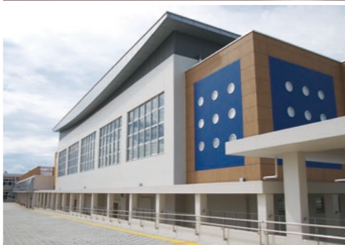
PFI方式で建設、管理・運営されている消防署(上)および大森小学校(下)のモダンなたたずまい
