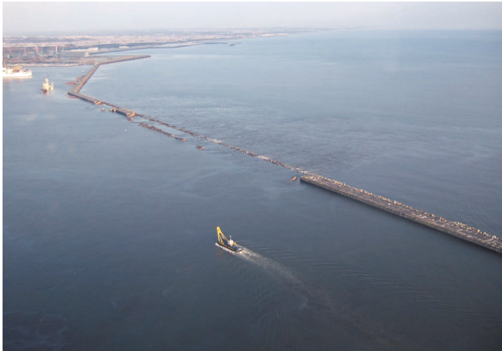
津波により1500mにわたって倒壊した八太郎北防波堤(八戸港)
