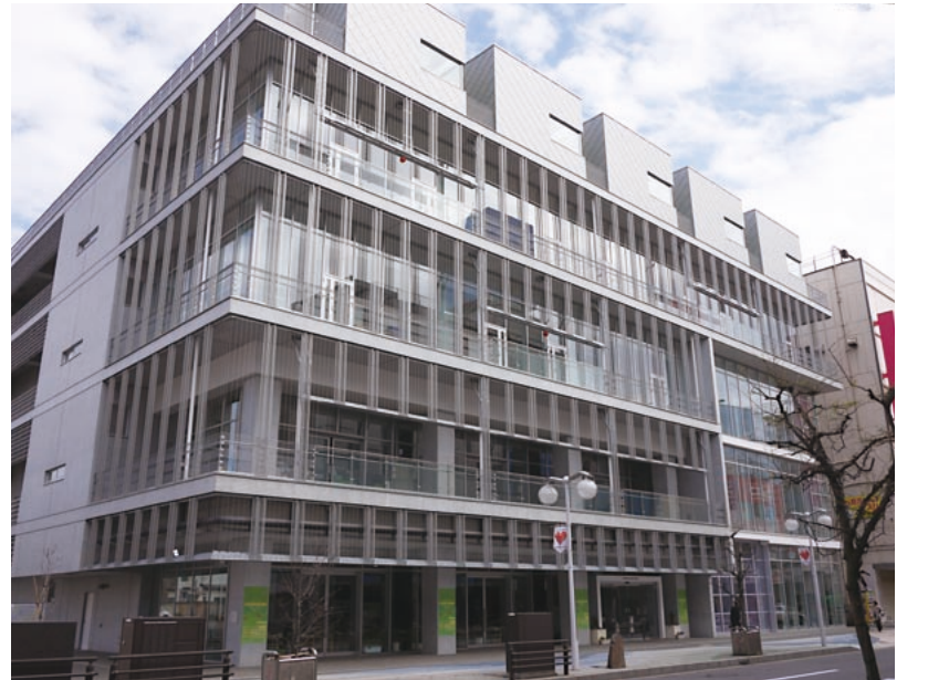
八戸ポータルミュージアム「はっち」の外観
