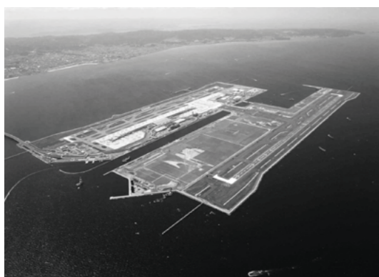
日本の国際拠点「関西国際空港」
