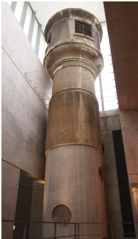
近年まで使われていた取水塔と 中世に改修された際に埋められた樋(狭山池博物館)
