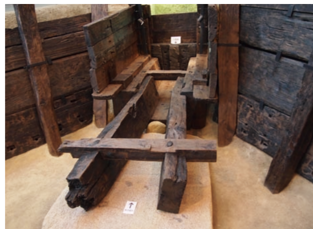
近年まで使われていた取水塔と 中世に改修された際に埋められた樋(狭山池博物館)
