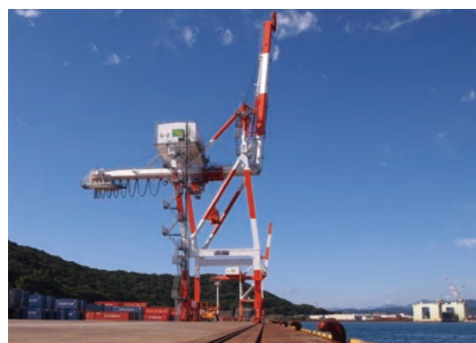
1時間に40個以上の処理能力を持つ強力なガントリークレーン
