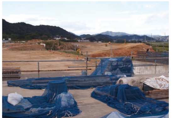
東九州自動車道の工事区間は既に日向市内に到達。ICの造成も終了し、完成間近
