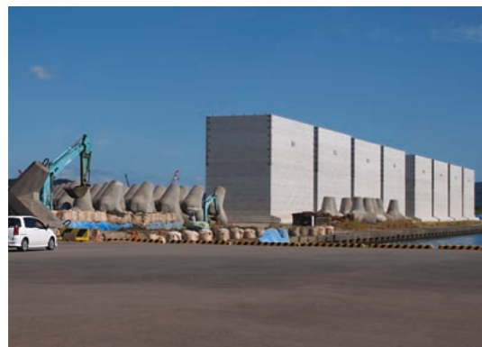
整備中の国際ターミナルのケーソン
