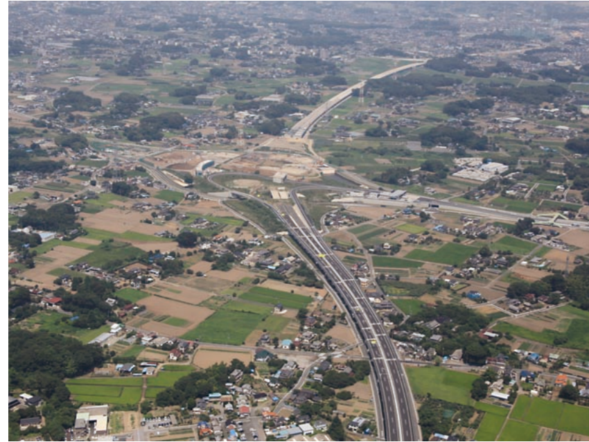
首都圏の骨格道路と期待される圏央道の桶川北本IC付近
