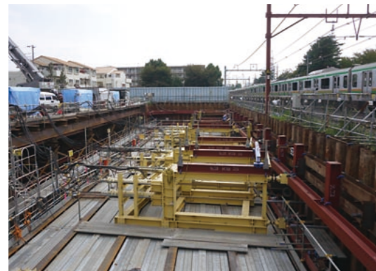
市内の圏央道工事も着々と進行中(JR高崎線・二ツ家踏切横)
