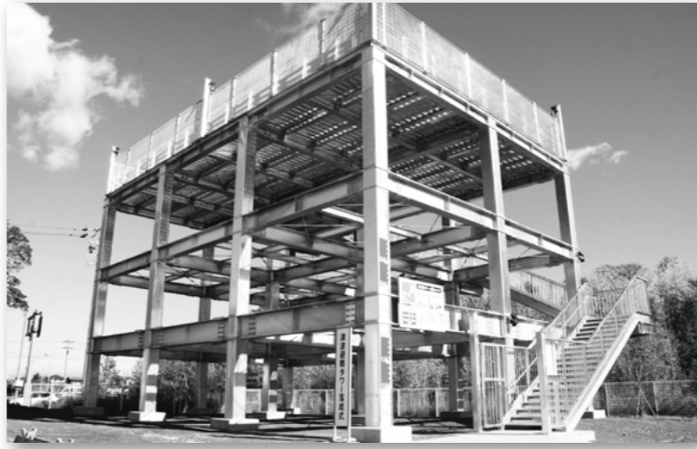
津波避難タワーの完成
