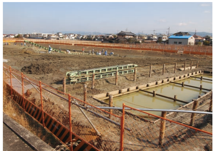
新名神高速道路の建設現場(遺跡調査)
