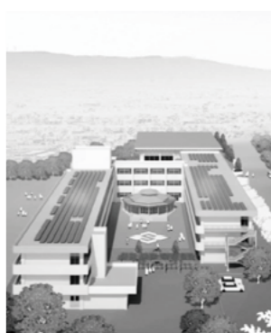
屋上に太陽光発電設備を設置するスーパーエコスクール
