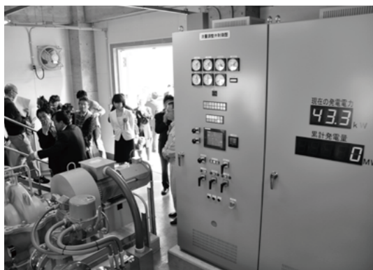
市内の浄水場で稼働する小水力発電施設
