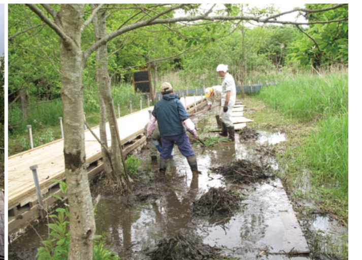
「守谷野鳥の森散策路」の建設中の様相
