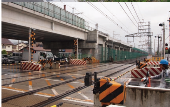
新市街地ゾーンは2つの鉄道駅に至近。工事が進む阪急の連続立体交差化事業
