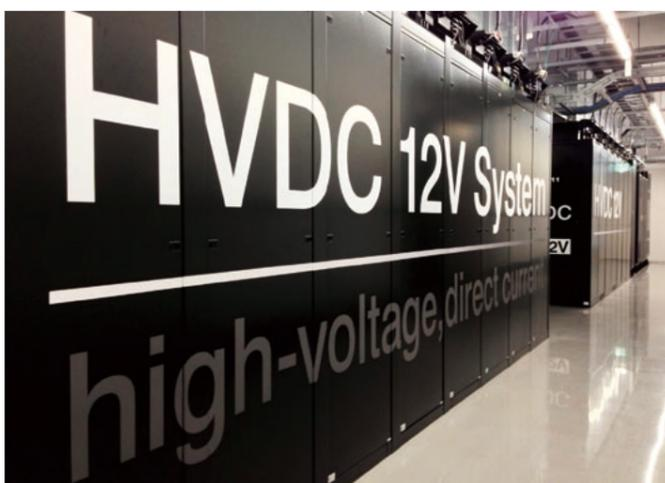
超電導直流送電実証実験で交流送電を受電する直流受電設備(さくらインターネット)
