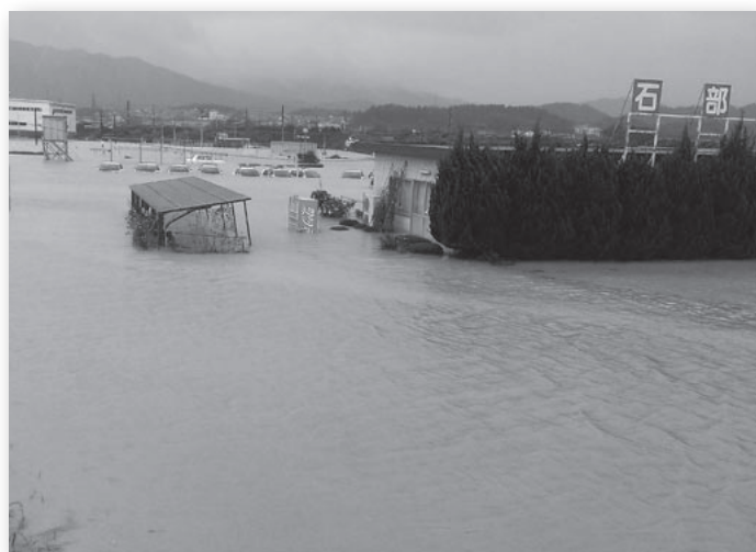
平成25年の台風18号による被害状況
