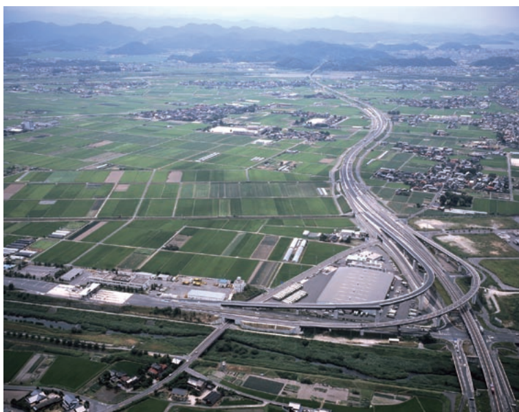
山陰自動車道と米子自動車道を結ぶ米子ジャンクション
