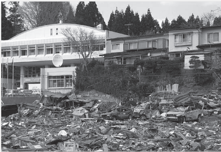
間近まで津波がきたが浸水を逃れた「宮古市田老総合支所」
