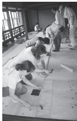
公募に応じた参加者らによる仲崎邸の床板の張り付け作業
