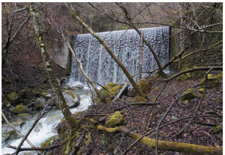
小水力発電(上村プロジェクト)で活用される予定の水源地
