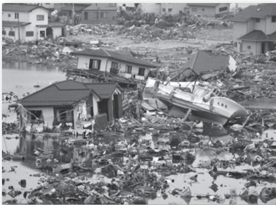
東日本大震災被災状況
