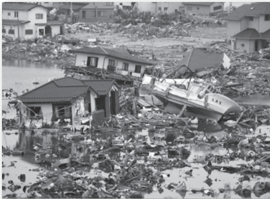
東日本大震災被災状況
