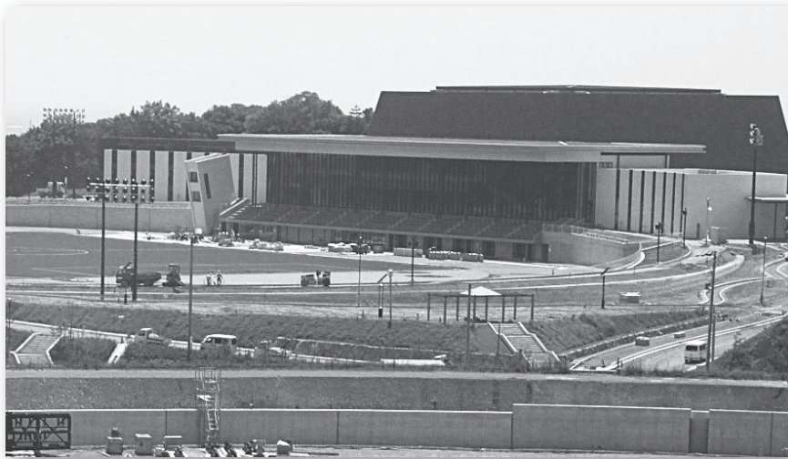
完成間近の陸上競技場と体育館
