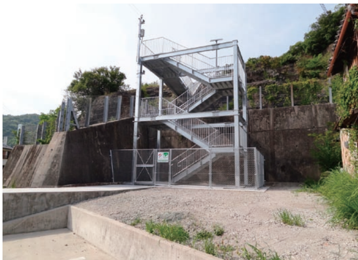
市内の丘陵部(池崎山)に設置された地震・津波の際の緊急避難用階段
