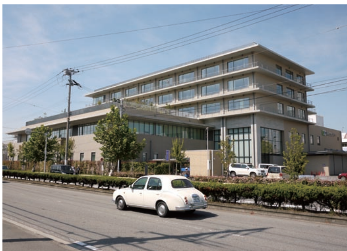
市民の安心・安全を支える海南医療センター(震災・津波時の緊急避難ビルを兼用)
