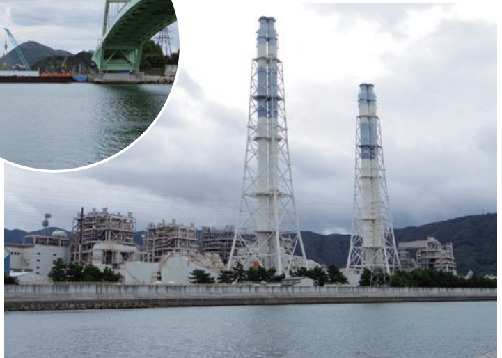
臨海工業地帯の周囲を巡る津波避けの防波堤・堤防
