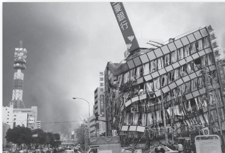
被災状況(その1)
