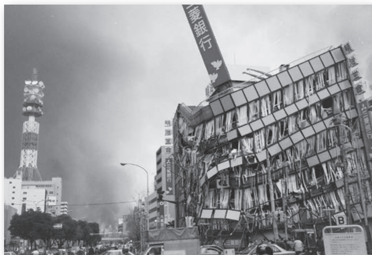
被災状況(その1)
