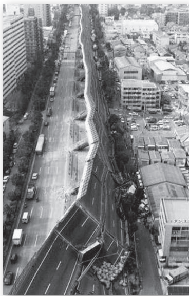
被災状況(その2)
