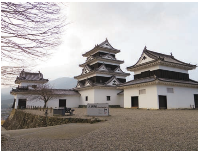
在来工法で木造復元された大洲城天守は歴史界注目のマト
