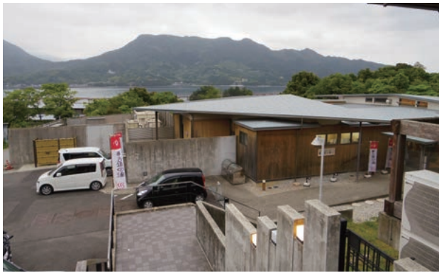
海洋深層水を活用して人気の温浴施設・夢古道の湯
