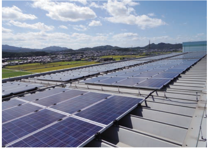
地元企業(甲西陸運)の屋根を活用した市民共同発電所式号機
