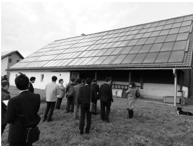
太陽光温水器と木質ボイラーの熱供給施設（ウアバウズドルフ村）
