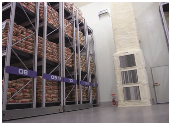
雪の冷風が送られるJA北魚沼の低温貯蔵庫
