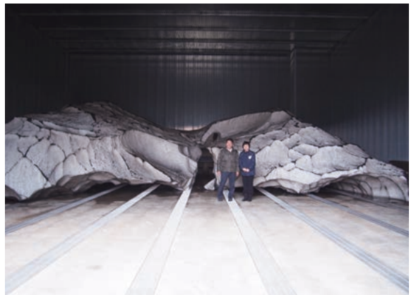
1500 tの雪が入るJA北魚沼の利雪型米穀低温貯蔵施設(写真は平成27年12月現在。この写真に写っている雪は平成27年2月の雪)
