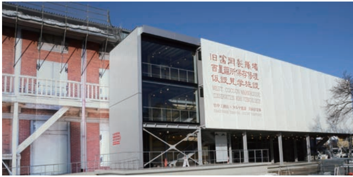
富岡製糸場西置繭所保存修理工事の見学施設(富岡市)
