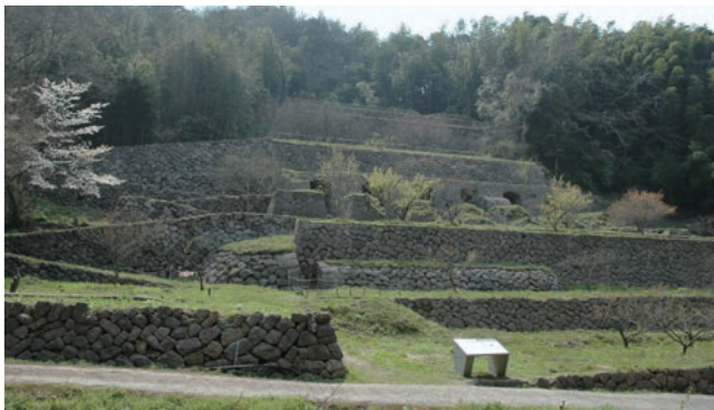
煉瓦造りの送風装置の一部が残る「清水谷製錬跡跡」(大田市)
